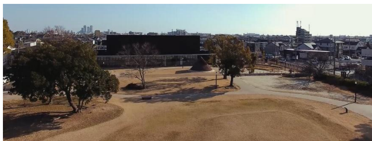
本館全景 (北から)
