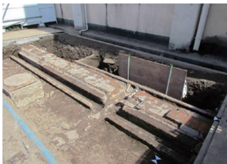
7-4 愛知県立第一中学校校舎基礎
